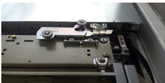
Figura 7. Enclavamiento mecánico y contacto de seguridad de puertas exteriores. Fuente: CBCM
